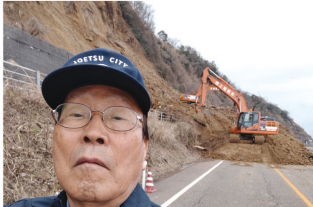
国道8号線 茶屋ヶ原の 現場
