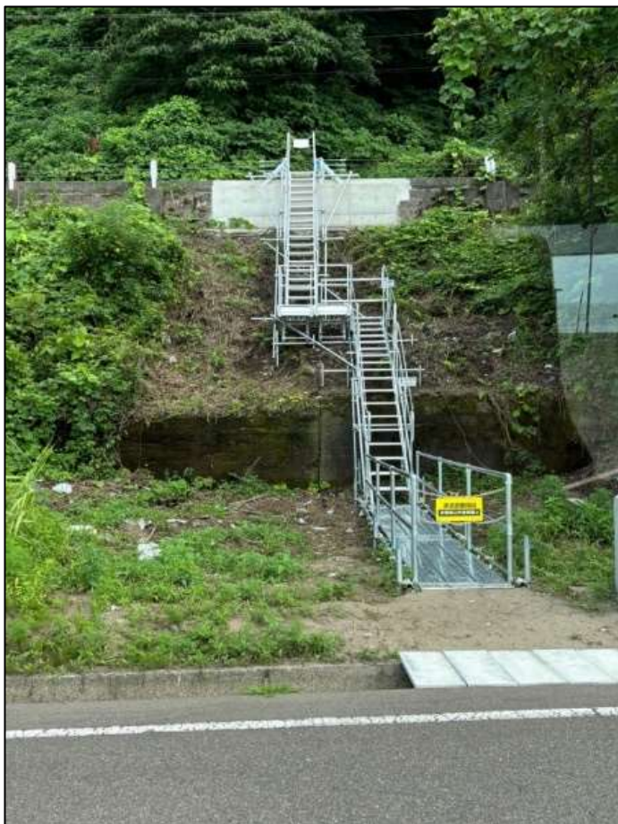
連絡調整会議の意見を踏まえ設置した津波からの避難階段
